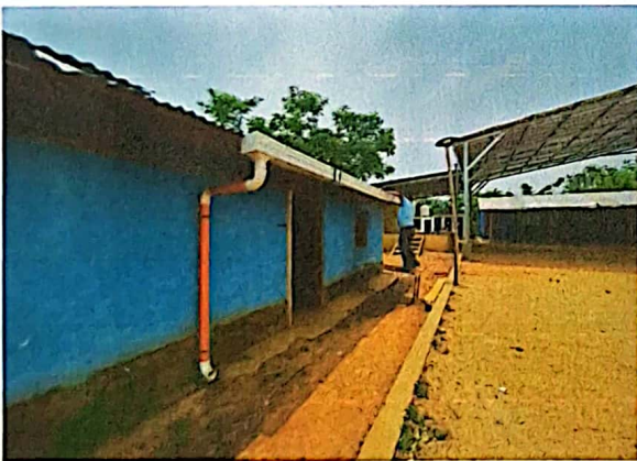
Foto 3: MEJORAMIENTO MODULO 11 Y 5, CANALES Y BAJADAS DE AGUA PLUVIAL
