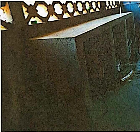
Foto 3: MEJORAMIENTO MODULO 9 (COCINA), REPARACION O SUSTITUCION DE AREA DE COCINA
