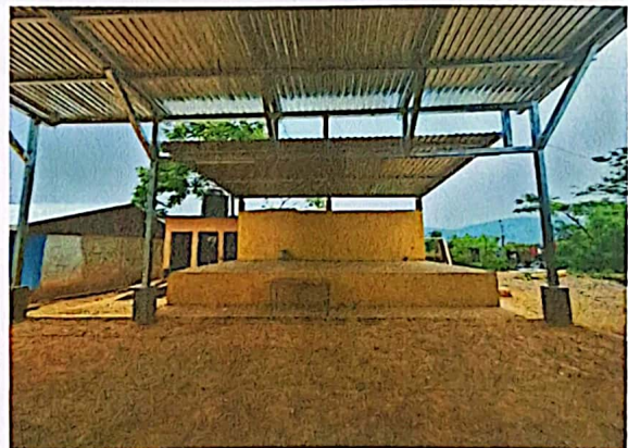
Foto 4: MEJORAMIENTO MODULO 5 (ESCENARIO), CUBIERTA DE LAMINA
