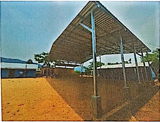
Foto 1: MEJORAMIENTO MODULO 11 (PATIO DEL ESTABLECIMIENTO), PORTICO, CUBIERTA DE LAMINA
