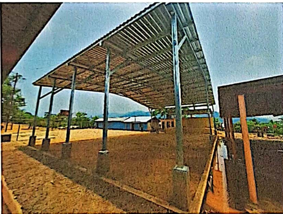
Foto 3: MEJORAMIENTO MODULO 11 (PATIO DEL ESTABLECIMIENTO), PORTICO, CUBIERTA DE LAMINA
