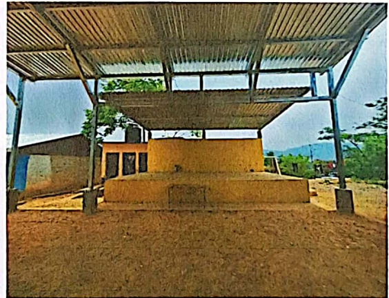
Foto 4: MEJORAMIENTO MODULO 5 (ESCENARIO), ESTRUCTURA DE TECHO
